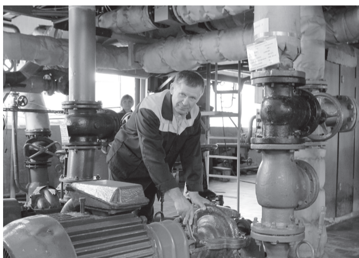
Профилактический ремонт проводится в котельной по ул. Пушкина, 4.
